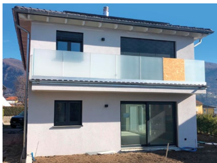
Qui sopra: costruzione a Rancate di casa monofamiliare prefabbricata in legno con locale interrato in pareti di cemento prefabbricato. In fase di realizzazione, GPC impresa edile .
