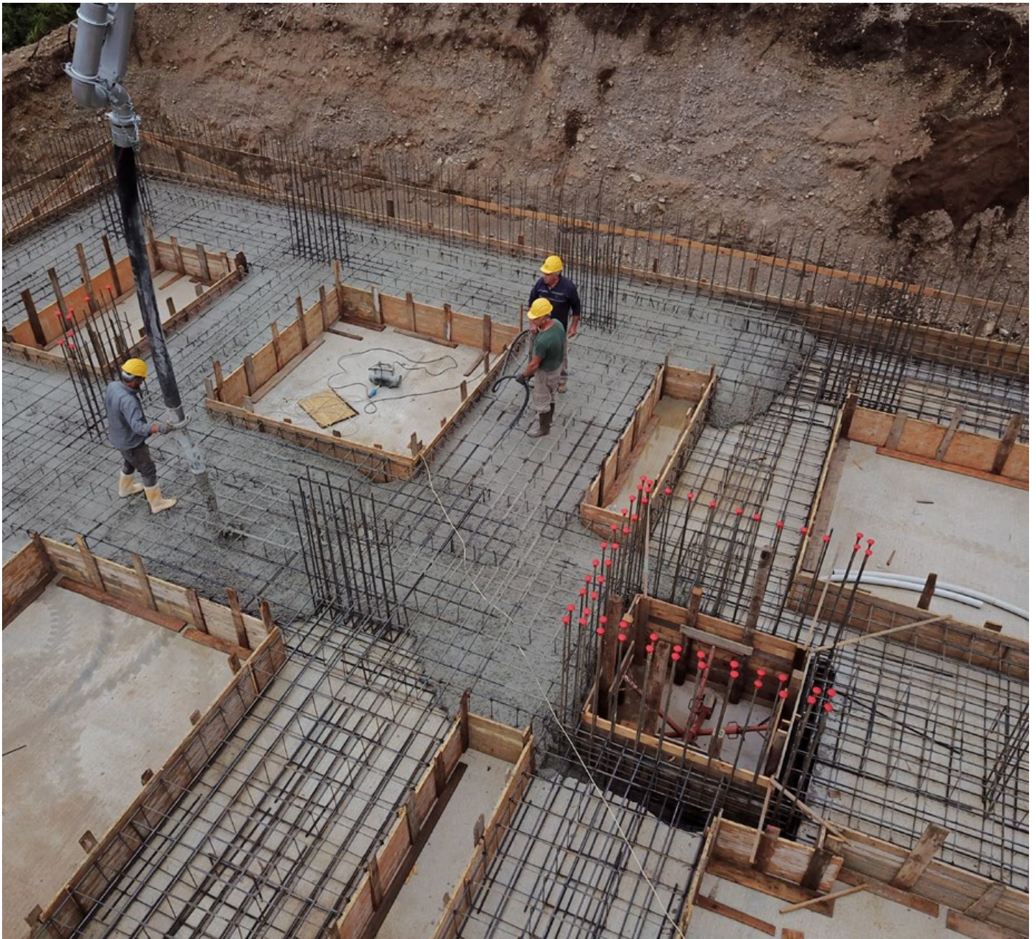
Cantiere in fase iniziale; realizzazione delle fondamenta di un edificio in seguito all'analisi della conformazione del territorio.
