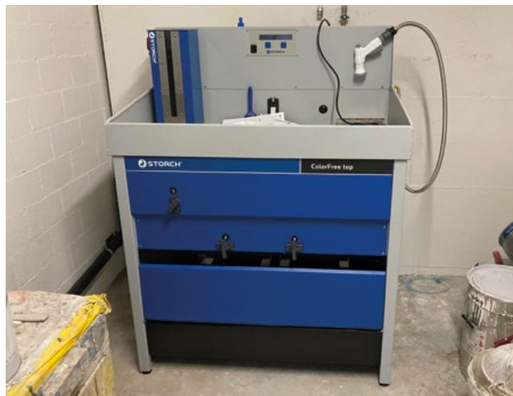
Impianto per la separazione delle acque sporche.
