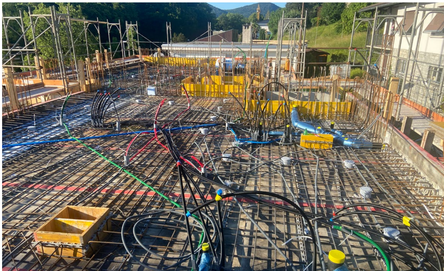
Soletta in calcestruzzo armato in fase di ultimazione con impianti elettrici e sanitari in getto
