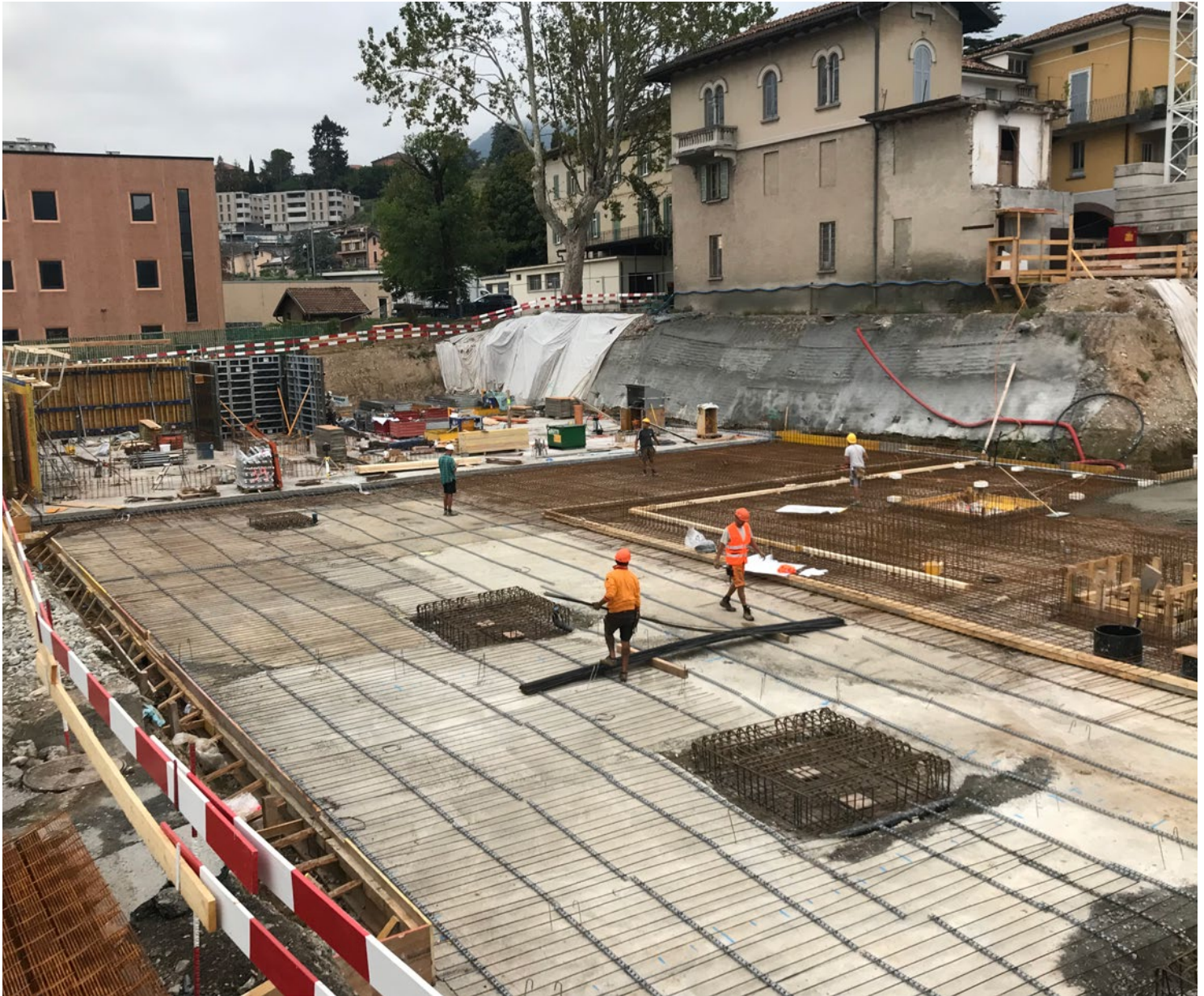
Realizzazione platea ed elevazioni nuova edificazione residenziale
