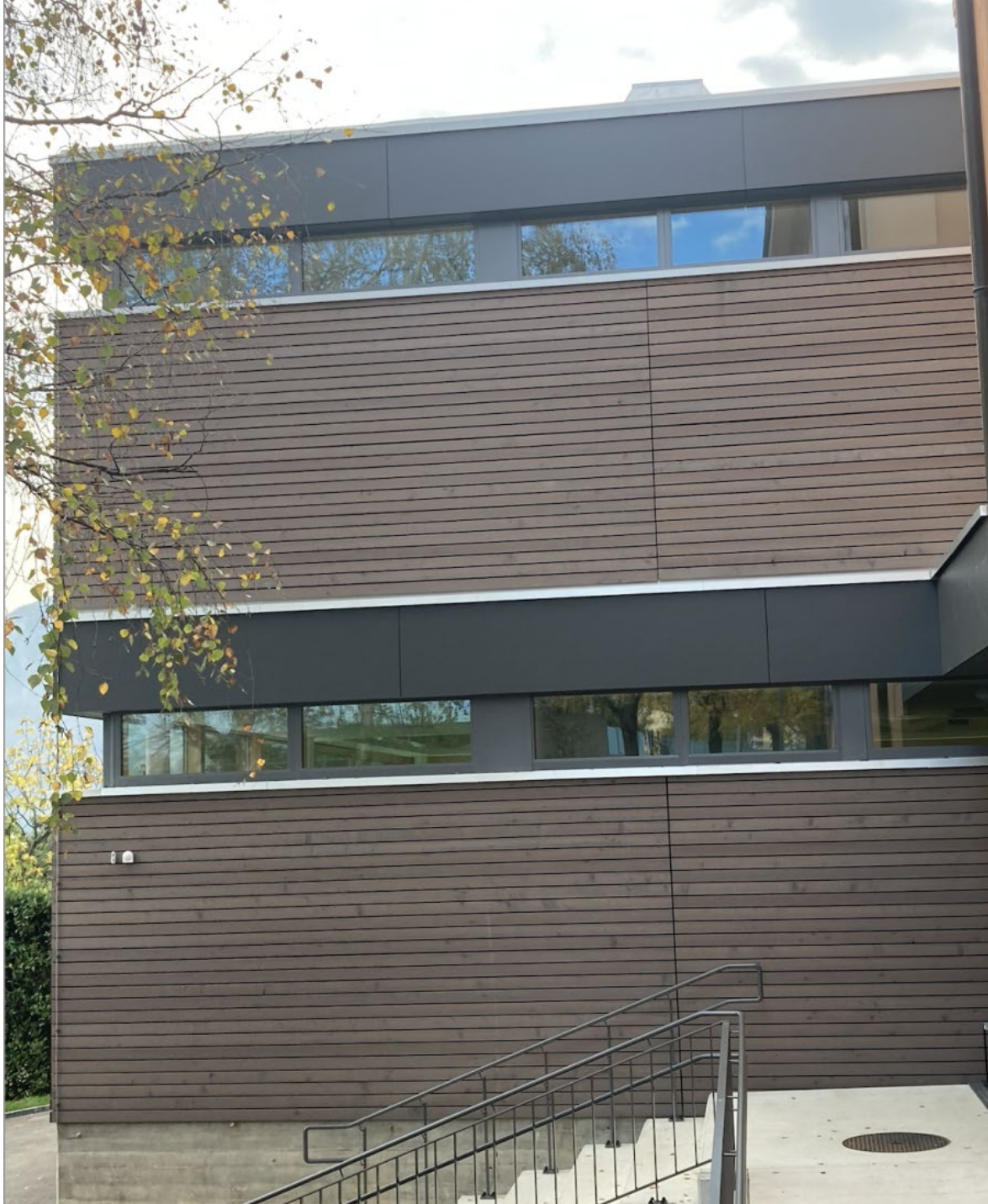
L'esterno della scuola dell'infanzia Collina d'oro: un esempio di prefabbricato in legno e vetro, certificato Minergie A (DL: Studio mn Sagl).
