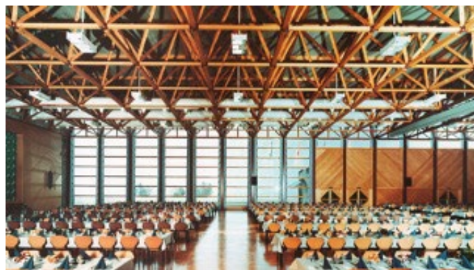
Due immagini della Sala Polivalente Arbon-TG. Primo impiego del lamellare di faggio, 1984. Immagini: Lignum.
