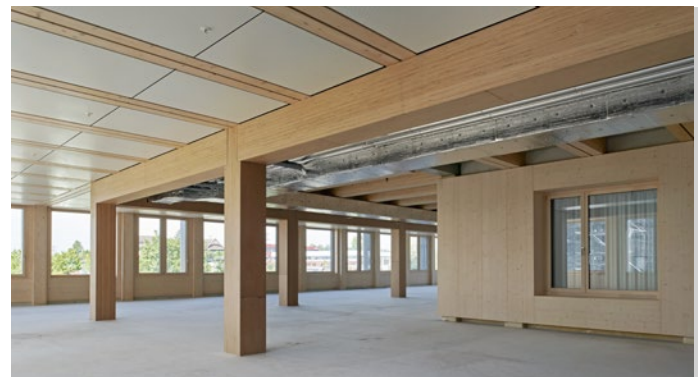
Impiego del faggio stratificato nel multipiano: Suurstoffi Risch Rotkreuz - 10 piani, 2018. Immagine: Michael Meuter, Zürich/LIGNUM.
